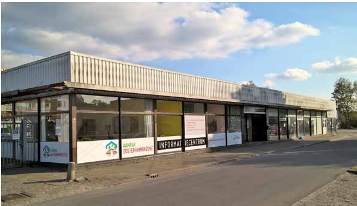
Tijdelijk informatiecentrum Oosterhamrikzone, Oosterhamrikkade 119, Groningen.
