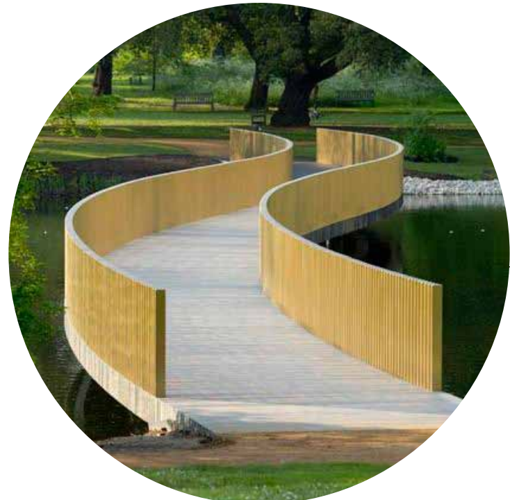
Wandell fiets brug
